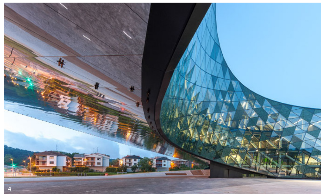
2. La cubierta de Zero funciona como una fachada captadora de energía. 3. Vista del complejo. 4 y 7. Los elementos triangulares opacos y translúcidos de la fachada cuentan con un dibujo impreso digitalmente que permite opacitar el vidrio. 5 y 6. El edificio Fundación Orona se reviste con una piel de chapa plegada perforada.
