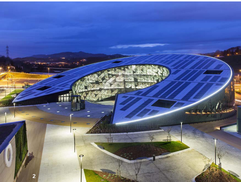
2. La cubierta de Zero funciona como una fachada captadora de energía. 3. Vista del complejo. 4 y 7. Los elementos triangulares opacos y translúcidos de la fachada cuentan con un dibujo impreso digitalmente que permite opacitar el vidrio. 5 y 6. El edificio Fundación Orona se reviste con una piel de chapa plegada perforada.
